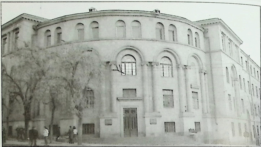
Здание Ереванской ДМШ им.Саят-Новы (архитектор – Геворг Таманян). Сдано в эксплуатацию в 1959 году
